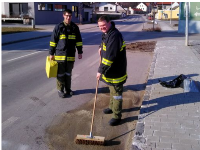
Binden von ausgelaufenem Motoröl
